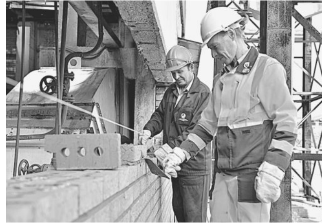
Константин Григорьев и Нурислам Мурзин производят кирпичную кладку стен.
